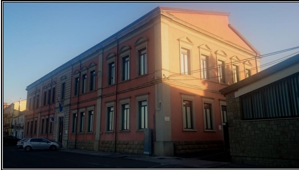
Foto 2 - Esterno veduta d'insieme
