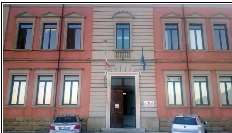
Foto 1 - Esterno ingresso principale
