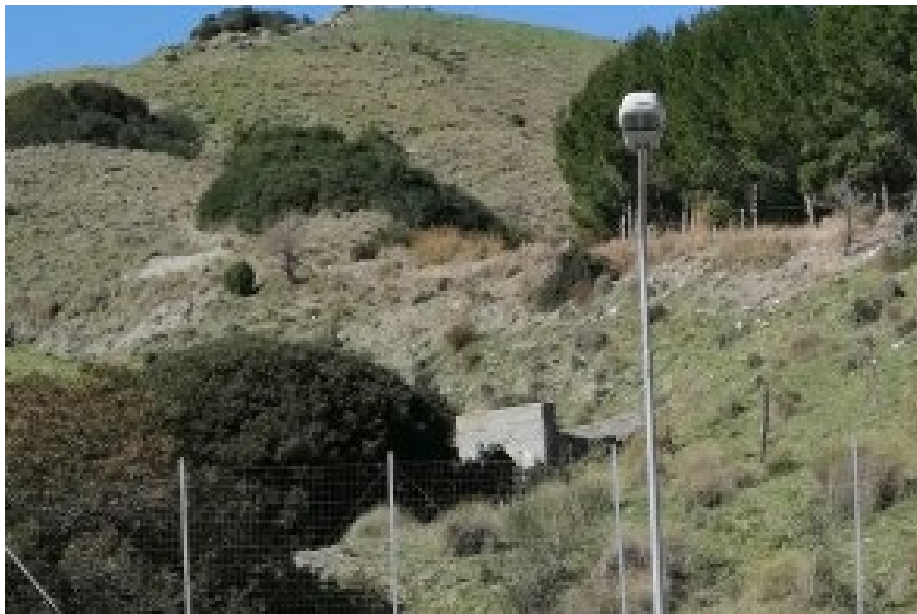
Fig .14 - Sbocco attraversamento sotto strada
