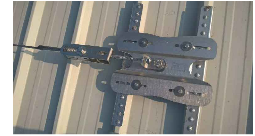
PART. 1 PIASTRA SHIELD INIZIO LINEA VITA
